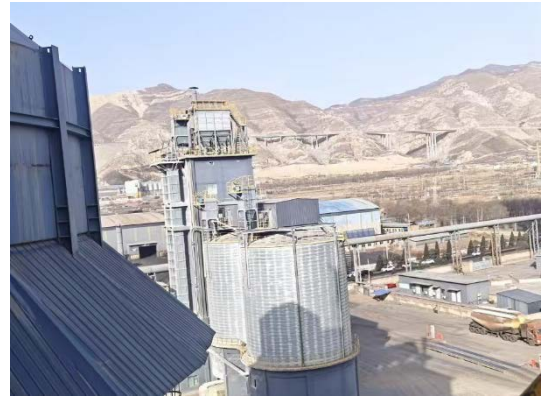
成品筛分除尘器及排气筒 DA005
