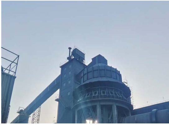
筛分、散装、筛上料除尘器及排气筒 DA002
